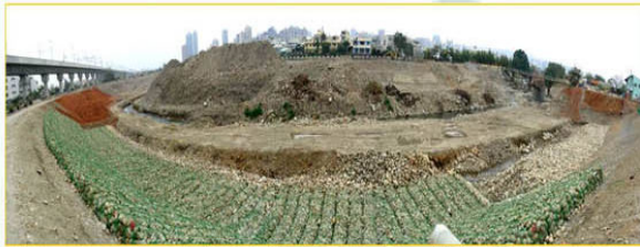
圖5. 整河段以石籠整治生態景觀瞬間全毀，車路巷橋至永安橋段，97/02/11
